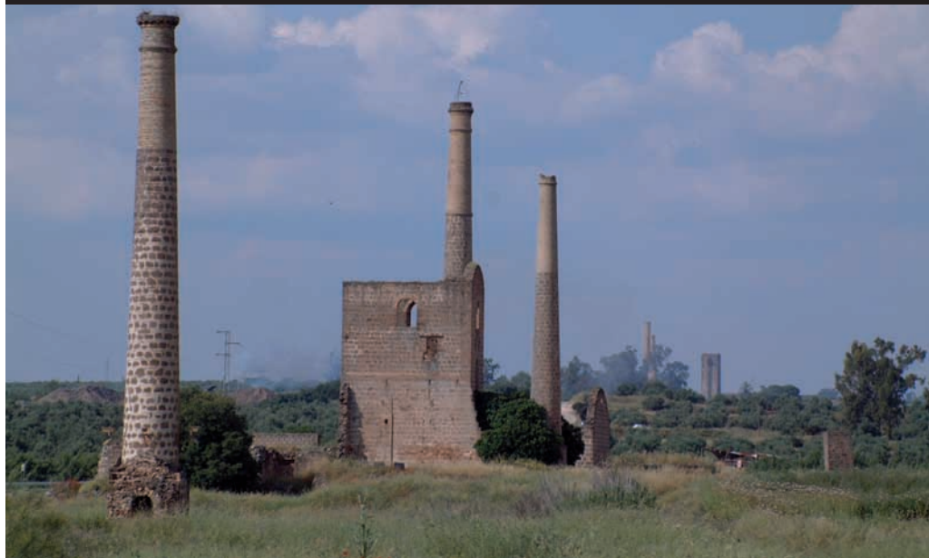
POZO SANTA ANNIE. MINAS LA TORTILLA, JAÉN. FOTOGRAFÍA CEDIDA POR LA ASOCIACIÓN COLECTIVO PROYECTO ARRAYANES.
