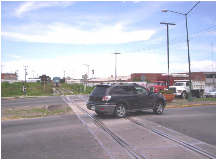
Cruce ferroviario en la Av. Ignacio Zaragoza. Obsérvese la falta de dispositivos, señalización y marcas.
