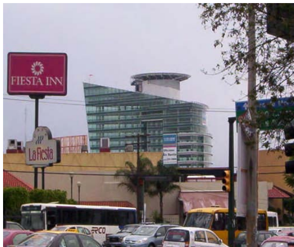
Helipuerto ubicado en la parte superior del centro comercial "El Triangulo de la Animas.
