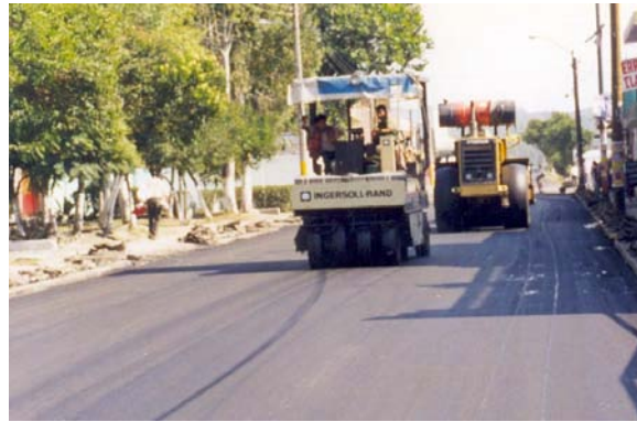
Proceso de compactación de carpeta asfáltica, después de haber sido recuperada la superficie de rodamiento.
