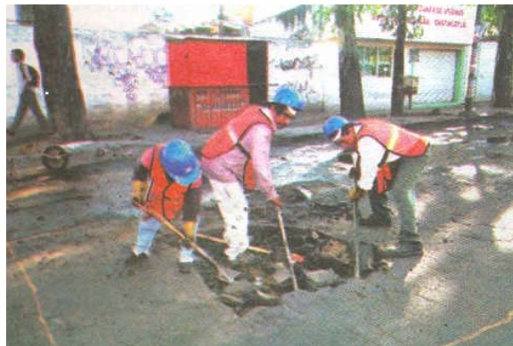
Proceso de bacheo, en diferentes vialidades del Municipio de Puebla.
