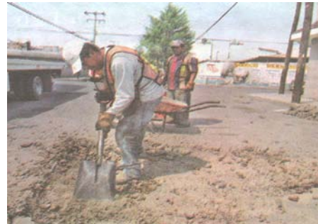
Proceso de bacheo, en diferentes vialidades del Municipio de Puebla.
