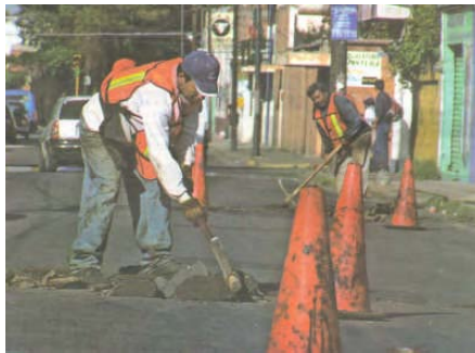
Proceso de bacheo, en diferentes vialidades del Municipio de Puebla.
